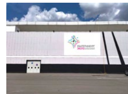
Печать/монтаж сетки на фасаде павильона №1
